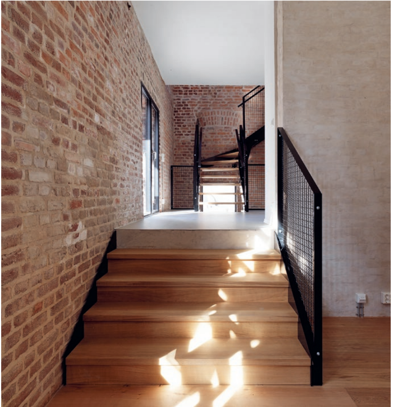
Interiør transformert del: Sekkeskurte yttervegger, slømet innervegg
