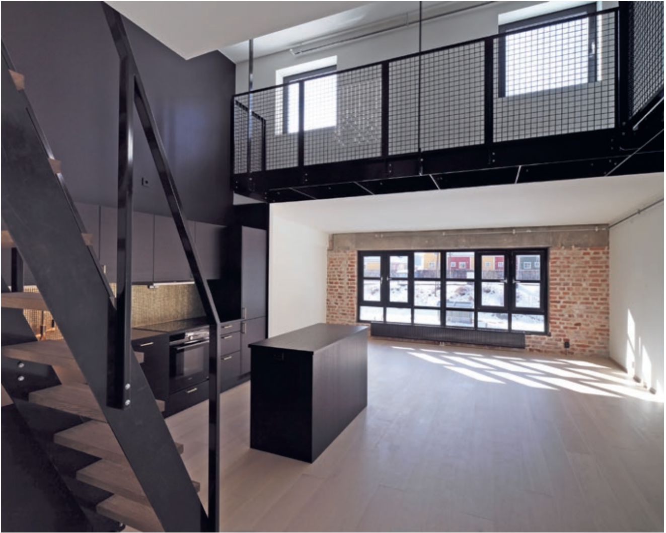
Leiligheter over flere plan gir spennende romforløp. Gjennomgående materialbruk i sekkeskurt tegl, eik og sort stål
