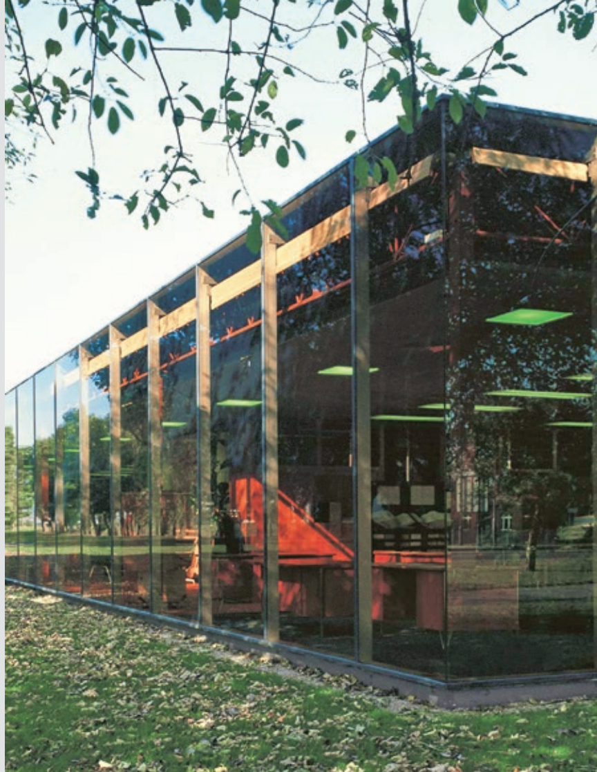
Lynx House, tidligere IBMs hovedkvarter i Cosham, Storbritannia, 1971. Foster + Partners. Foto: Foster + Partners
