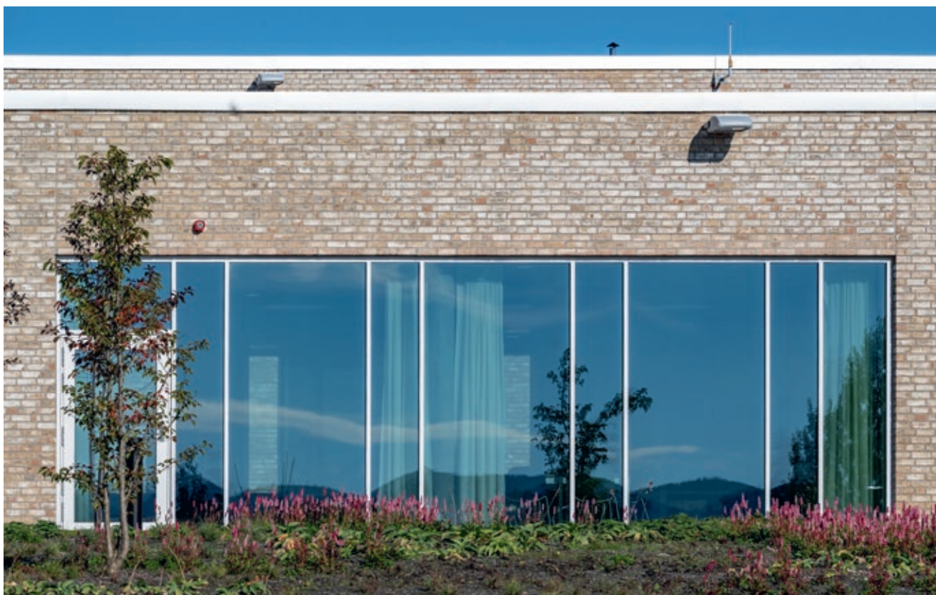
Naturen og dagslyset trekkes inn i bygget gjennom store vinduer og glasspartier. Beplantningen er basert på lokale arter
