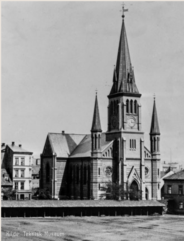
Jarhuset – arkitekt Georg Foss – ferdigstilt 1935 – ble murt med gjenbrukstegl fra Johanneskirken på Kristiania torv (bygget i 1878, revet i 1928 pga. setningsskader )
