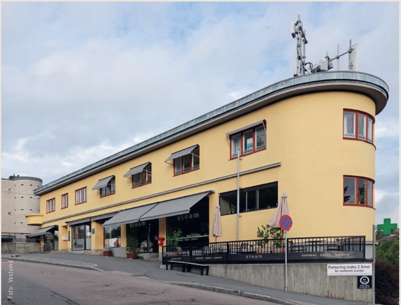
Jarhuset – arkitekt Georg Foss – ferdigstilt 1935 – ble murt med gjenbrukstegl fra Johanneskirken på Kristiania torv (bygget i 1878, revet i 1928 pga. setningsskader )
