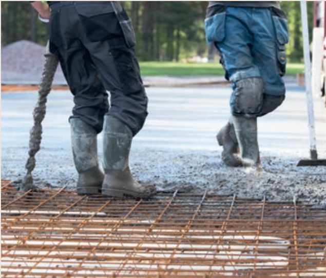
Figur 6: Tolags armering er viktig for å kontrollere spenninger i ekspansjonsfasen i øvre sjikt
