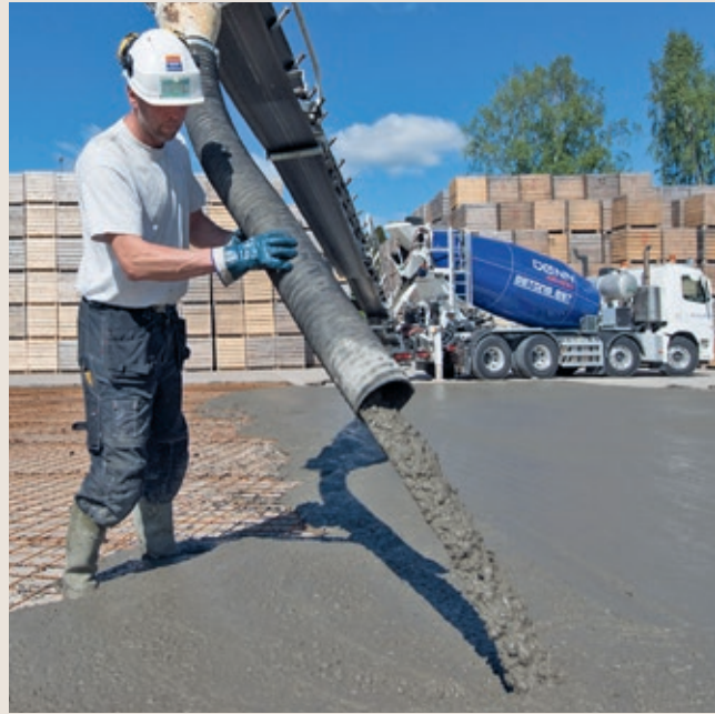
Figur 3: Riktig proporsjonering og god logistikk på byggeplass bidrar til at store flater kan legges uten støpeskjøter og uten feltinndeling
