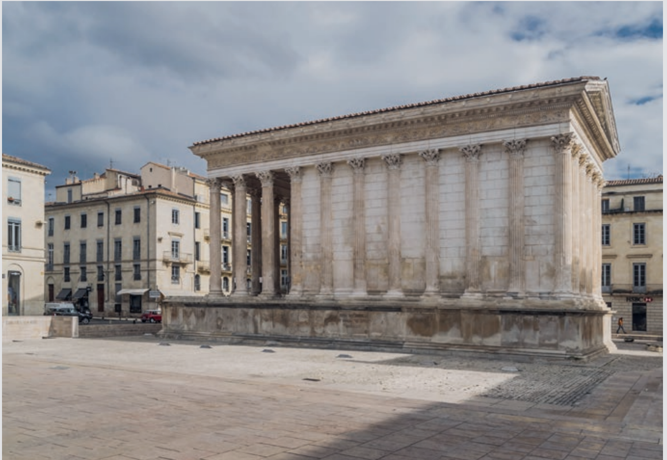
Romersk tempel. Maison carrée, Nîmes, Frankrike. (I. århundre evt.) er verdens best bevarte romerske tempel. Den tette, hvite kalksteinen i vegger, entablatur og ni meter høye korintiske søyler kom fra Bois des Lens. Det er kun ett rom inne i templet, med en pronaos (vestibyle) utenfor. Taket på pronaos bæres av ti frittstående søyler. De øvrige tjue søylene er integrert med veggene. Kilde: Foto: Krzysztof Golik (wikimedia). Nederst en illustrasjon fra 1800-tallet
