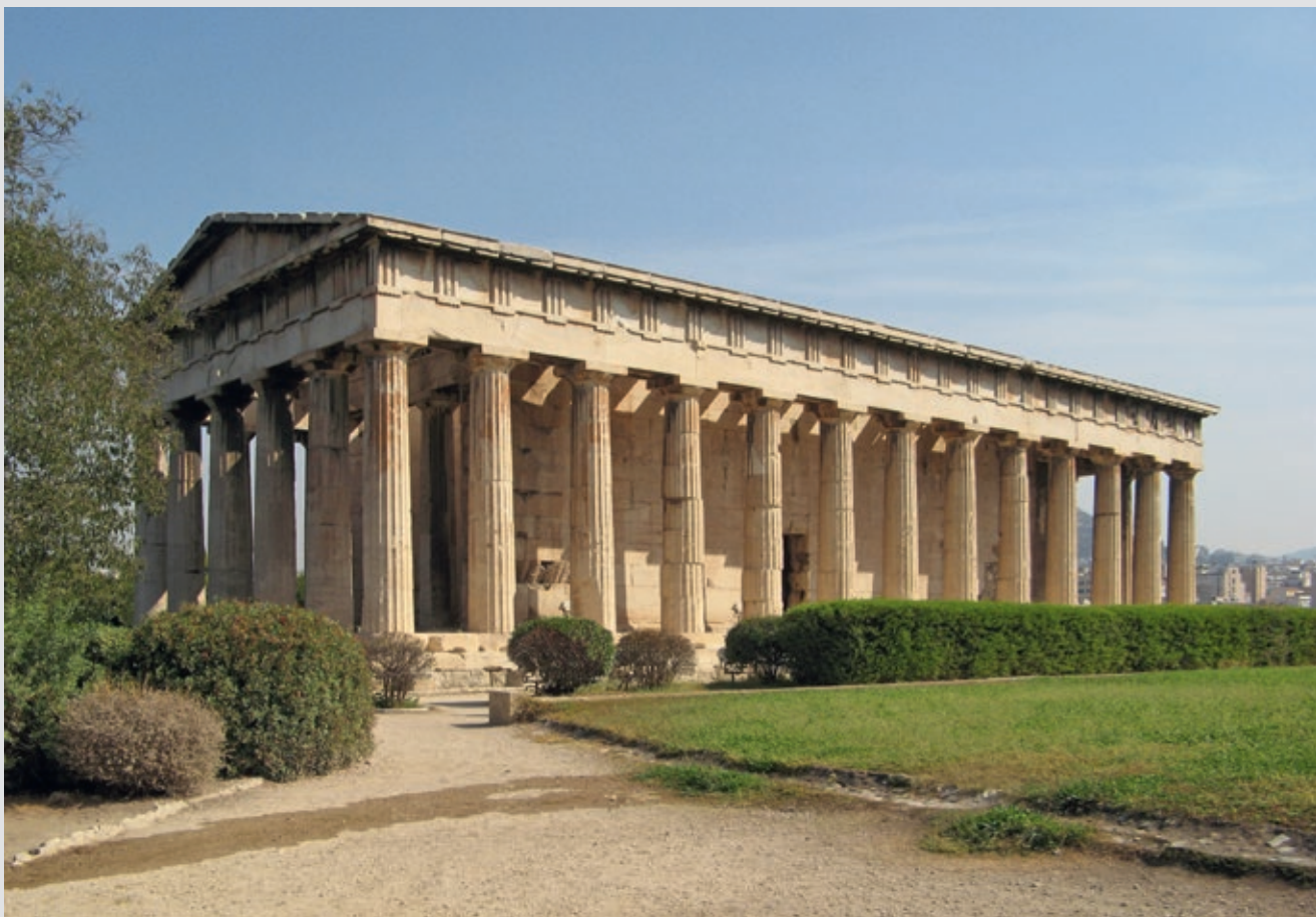
Hephaestustempelet Athen, 449–415 fvt., opptegning av Stuart James & Revett Nicholas i 1794. Tempelet har dorisk søyleorden blant annet kjennetegnet med at søylene treffer basen/gulvet (stylobat) direkte uten søylefot (torus). Foto: Storeye, wikimedia
