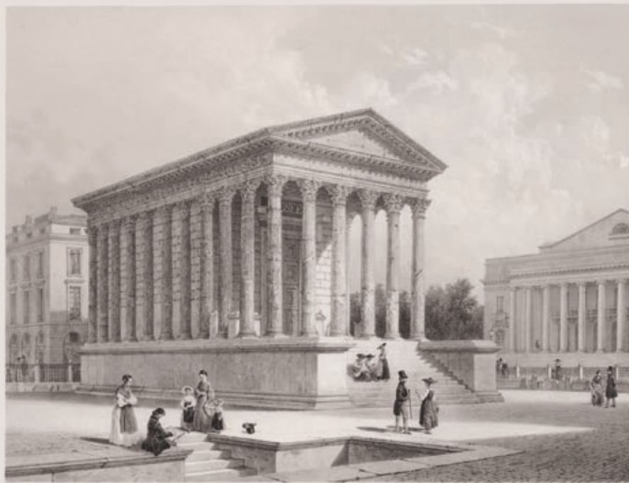
LA MAISON CARRÉE
