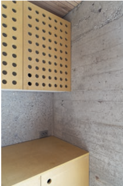
På kjøkkenet kan man se de ulike forskå- lingene fra da huset ble bygget i 1965
