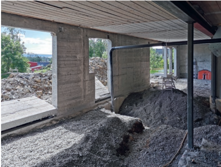
Gulvet ble pigget opp, etterisolert med 20 cm isolasjon og radonsperre, før det nye gulvet med vannbåren varme ble støpt. Ekstra utgraving av gammel pukke ga økt takhøyde.
