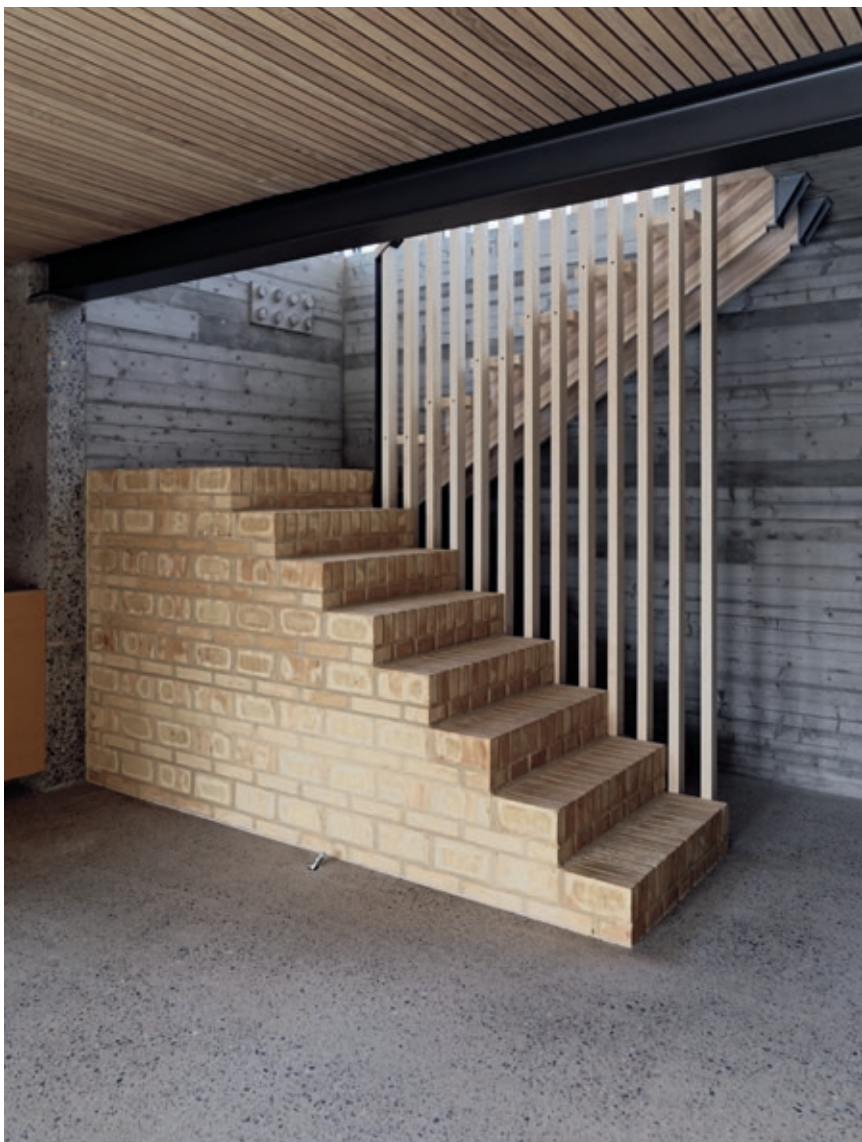
I trappen møtes underetasjens murale karakter og overetasjens lette trekonstruksjon
