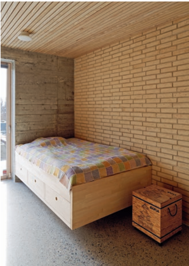
Innredningen i gjennomfarget gul mdf forsterker den varme atmosfæren som teglen skaper Nye innvendige vegger er murt med gul tegl. De buede veggene er utført i stående forband for å få presis geometri
