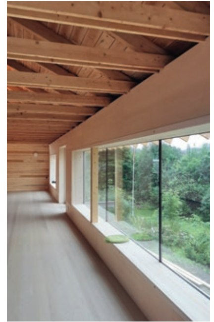
I hovedetasjen er de originale takstolene eksponert, og med nye vindusåpninger mot syd blir oppholdsrommet luftig og åpent
