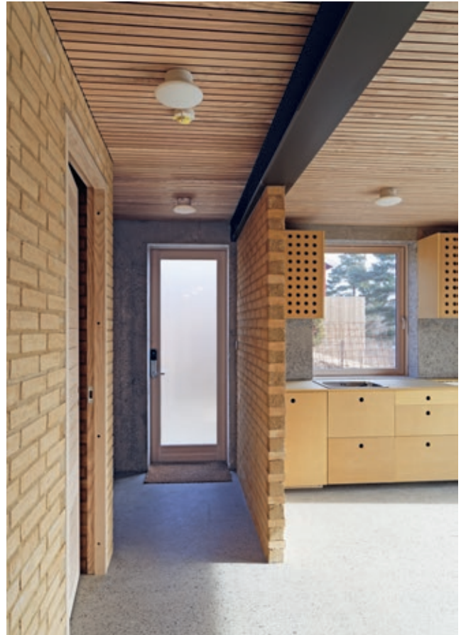
Innredningen i gjennomfarget gul mdf forsterker den varme atmosfæren som teglen skaper Nye innvendige vegger er murt med gul tegl. De buede veggene er utført i stående forband for å få presis geometri
