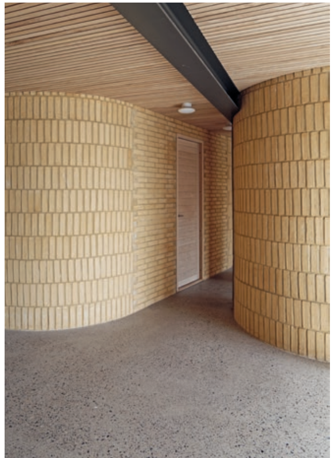
Innredningen i gjennomfarget gul mdf forsterker den varme atmosfæren som teglen skaper Nye innvendige vegger er murt med gul tegl. De buede veggene er utført i stående forband for å få presis geometri
