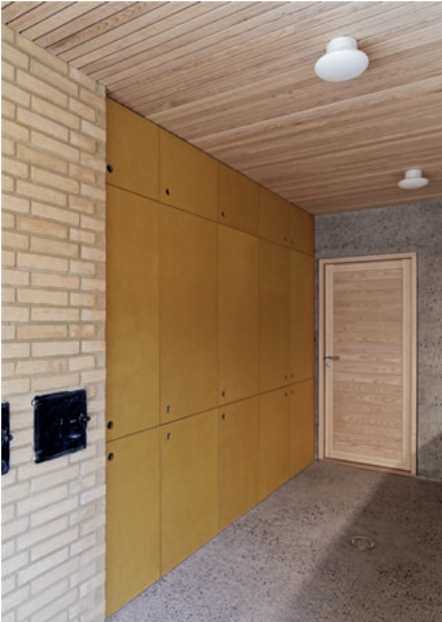
Innredningen i gjennomfarget gul mdf forsterker den varme atmosfæren som teglen skaper Nye innvendige vegger er murt med gul tegl. De buede veggene er utført i stående forband for å få presis geometri
