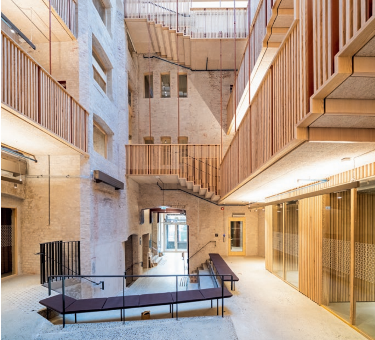
Det lyse betonggulvet i 1. etasje har en slipt, matt overflate som er poretettert og forseglet
