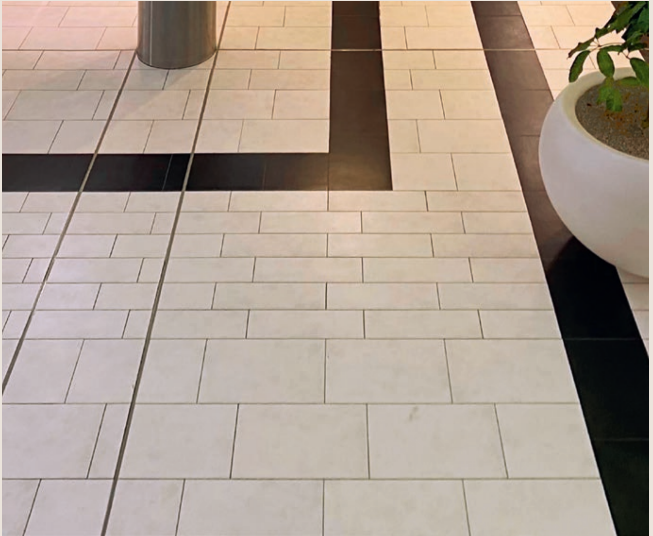
Figur 1: Med stabilt underlag holder et flislagt gulv hele byggets levetid
