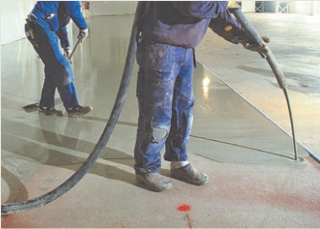
Figur 8: Selvutjevne avrettingsmasser pumpes ut, herdner raskt og gir en plan overflate. (Foto: NBKF)
