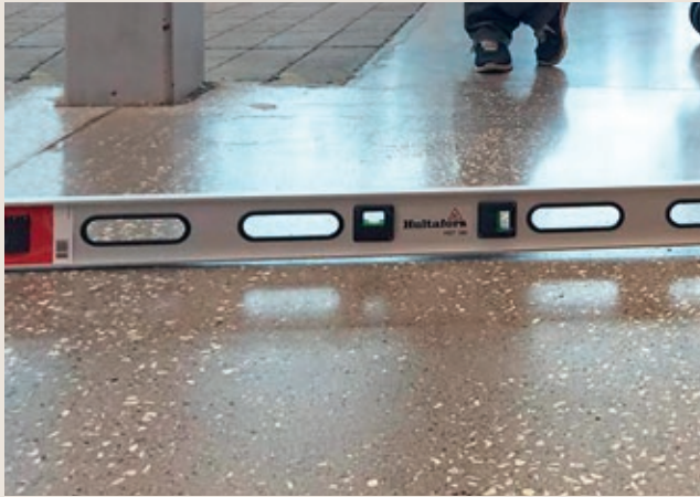
Figur 4: Kantreising må unngås for å sikre plane flater for flislegging. (Foto: AF-gruppen)
