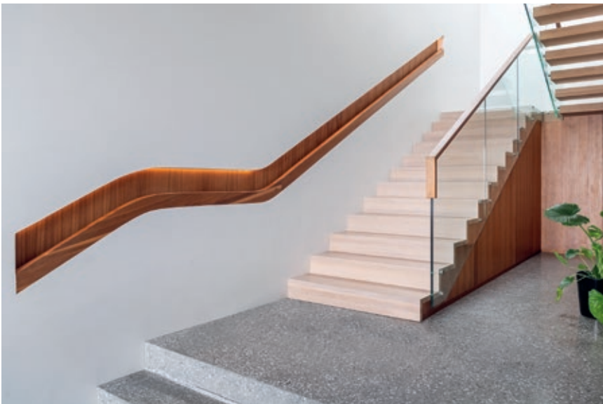
Trappen starter med trinn og vegger i plassenstøpt slipt betong
