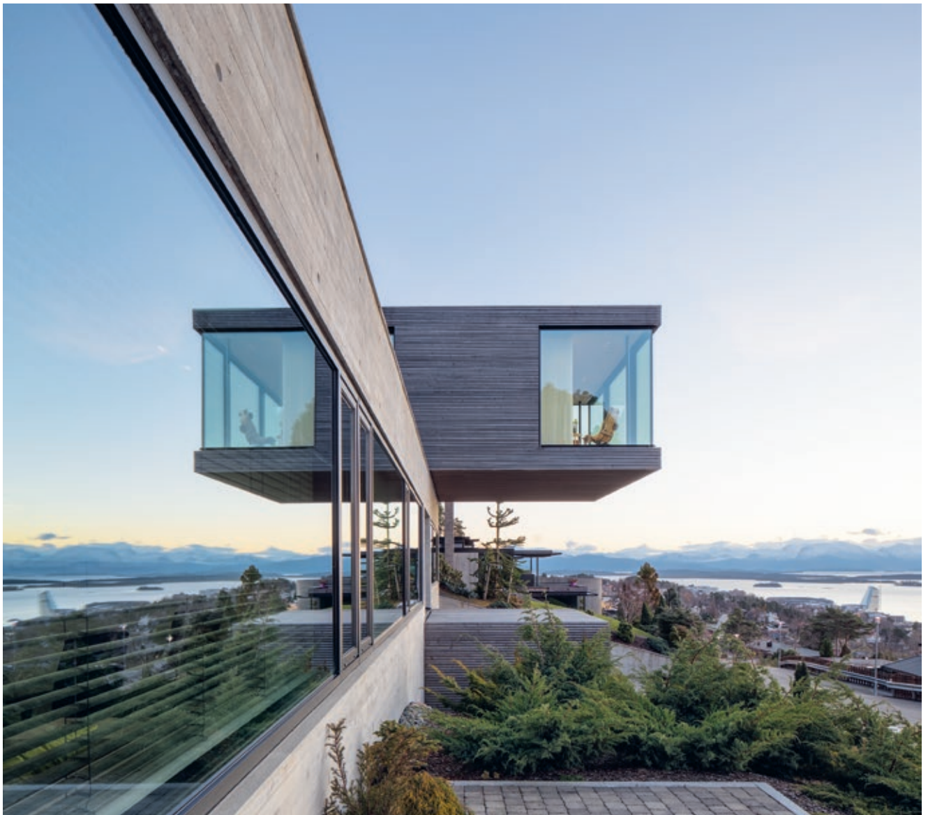
Utkragingen på ca. seks meter har en liten avstand til betongsokkelen og oppleves som svevende
