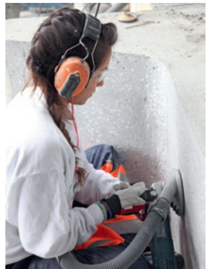
Trappesliping utført av Natalie Lange
