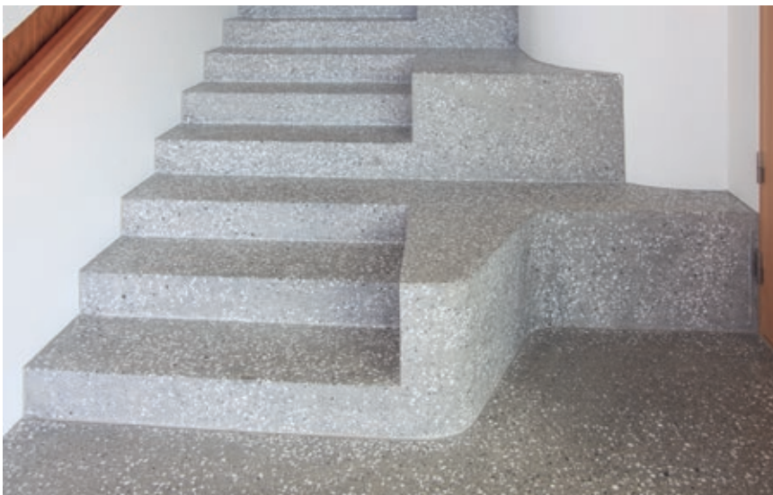
Trappen starter med trinn og vegger i plassenstøpt slipt betong
