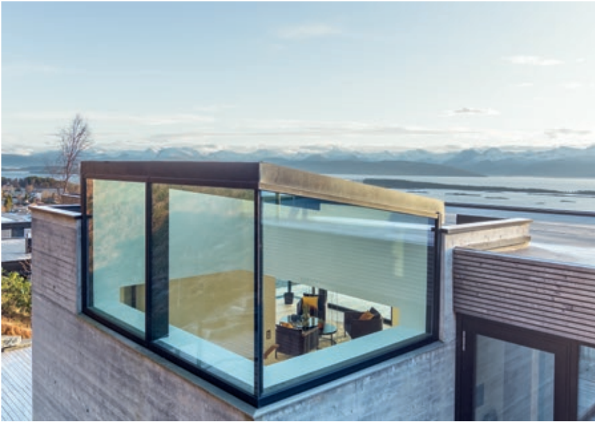
Trappen knytter etasjene sammen og formidler kontakt med fjord og fjell via store glasspartier i sør og med furuskogen i nord via et stort overlys i trapperommet
