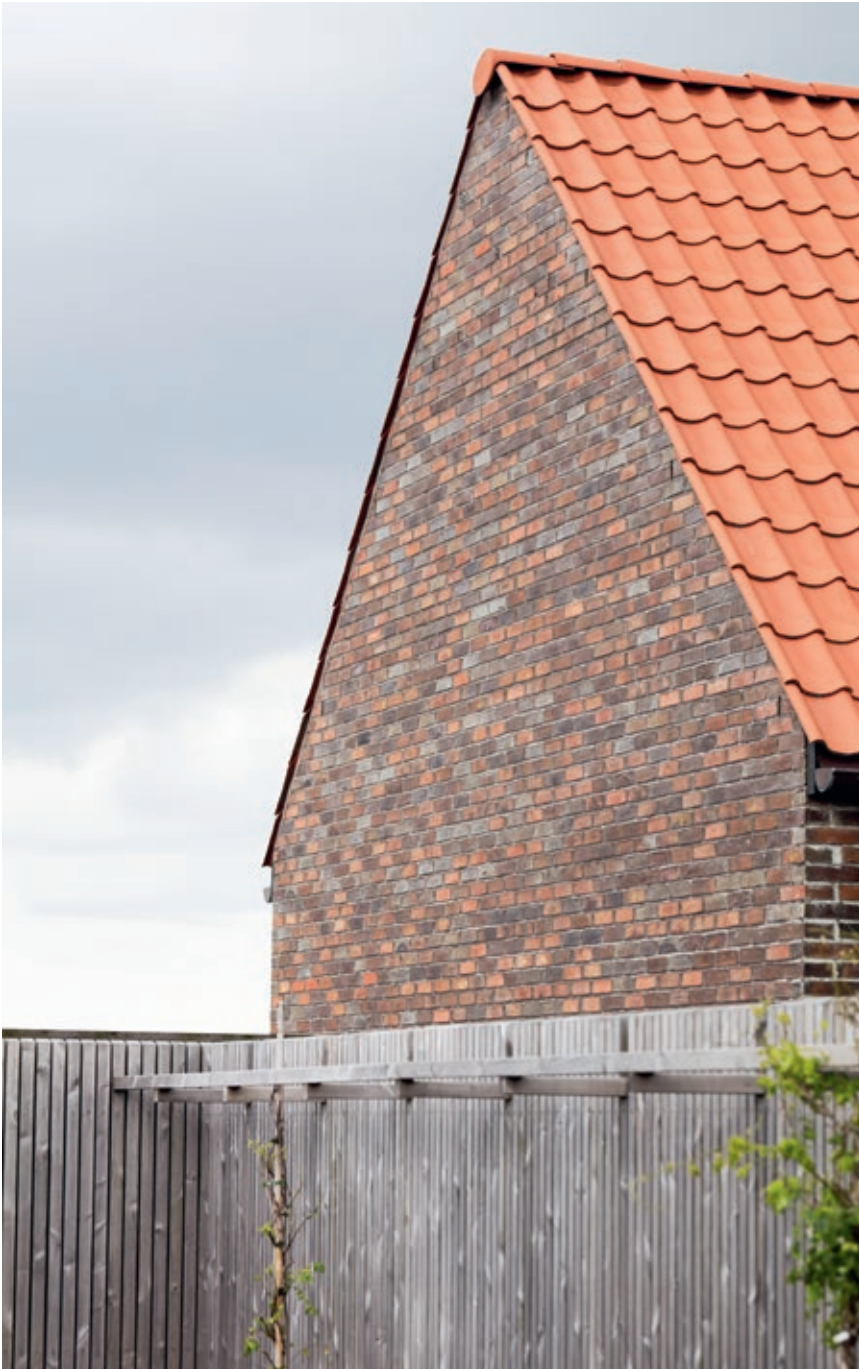
De røde teglpannene er tilpasset Jærhusets gamle Sandnespanner. Gavlstene er lagt i mørtel
