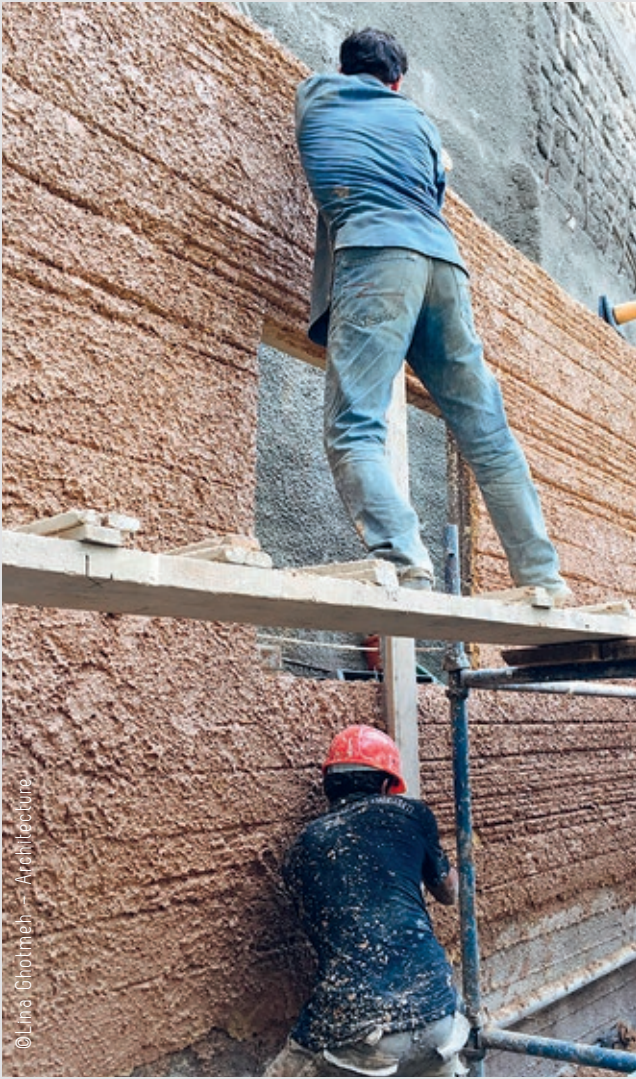
Pussen trekkes på betongvegg og 'gres' med sjablonger
