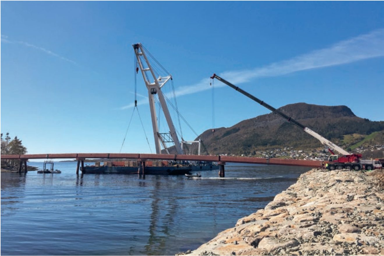
Fra monteringen. Hvert betongelement er 27,95 m langt Total bro lengde er 148,5 m, fri innvendig bredde 2,8 m og total bredde utvendig 3,6 m
