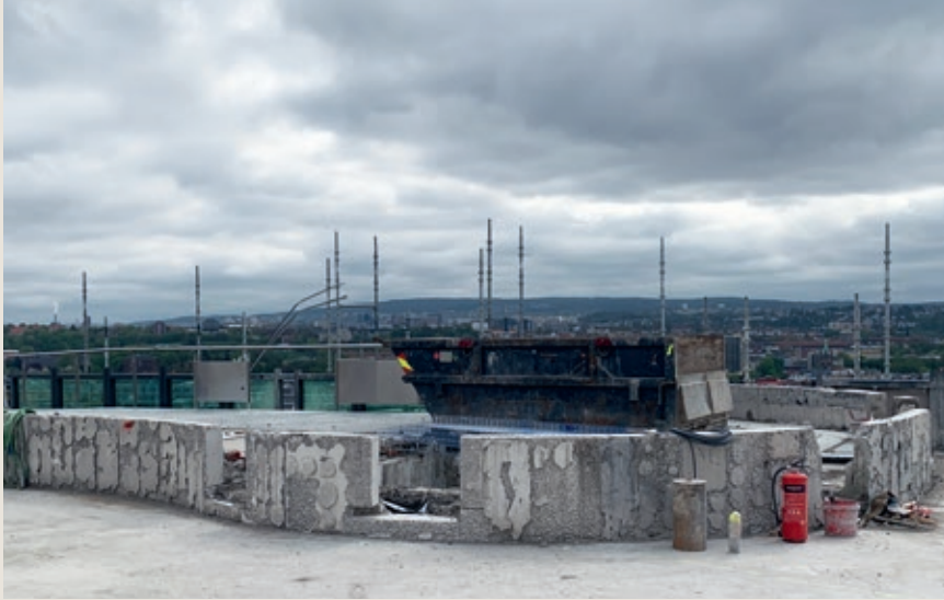
Toppen av 'fiolinkassa' stakk opp over dekket i 17. etasje
