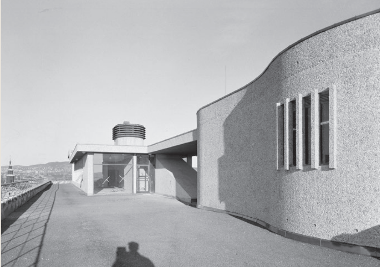
Fra taket på Høyblokken i Regjeringskvartalet 1958. Arkitekt Erling Viksjø (1910–1971). I bakgrunnen tilbaketrukket 16. etasje med salong, forværelse, statsrådsal og trapp fra 15. etasje. Til høyre heismaskinrommet (fiolinkassa). Foto: Teigens Fotoatelier (lisens CC BY 4.0)
