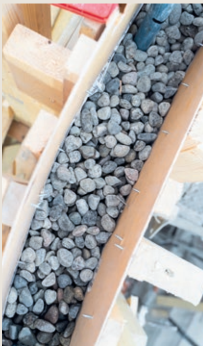
Injeksjonsrør monteres ned i forskalingen, som så fylles med natursingel. Til slutt injiseres sementvelling
