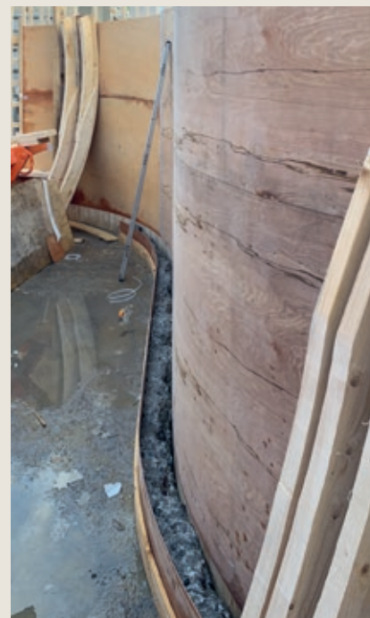
Forskalingen for den buede veggen bygges for hånd slik det ble gjort på 50-tallet. En fin utfordring for Skanskas lærlinger!
