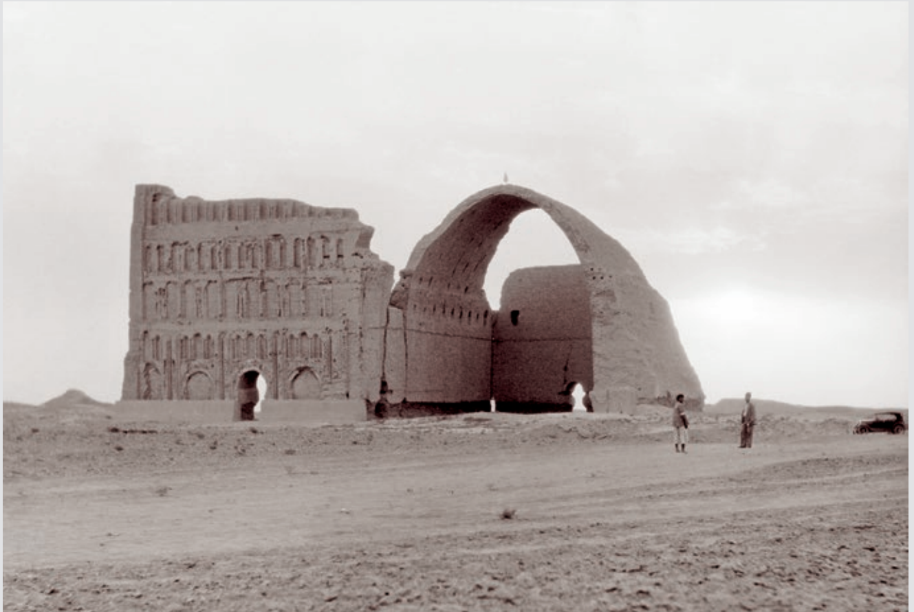
Ktesifonporten i Taq-e Kesra-palasset ('Khesras trone') i Ktesifon, Irak. Tønnehvelvet trolig bygget omkring år 250–500 e.v.t. Det er 37 meter høyt, 26 meter bredt og var opprinnelig 50 meter langt og er dermed verdens nest største tønnehvelv i uarmert murverk. Foto fra 1932: the United States Library of Congress's Prints and Photographs division (wikipedia)
