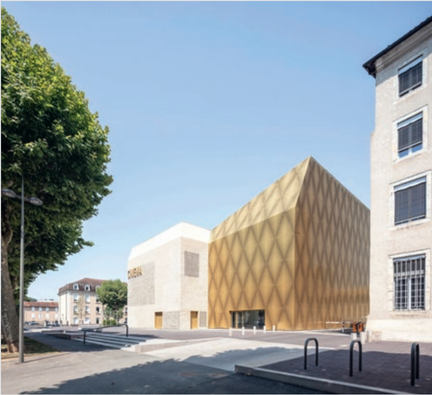
To volumer: det ene i teglstein og det andre av perforert, gyllent metall. Motstandsmuseet som ble revet for å gjøre plass for det nye kinoanlegget, får nå plass i bygningens øverste etasje med en inngang som er tydelig atskilt fra kinoen
