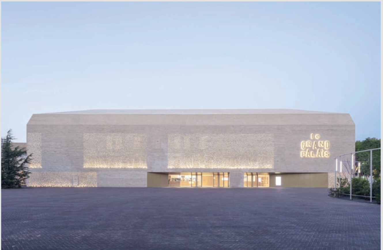
Sett fra vest, fra Place Bessières. Teglvolument er myket opp med store felt av gittermuring som gjør fasaden transparent. Denne skjermen med små glitrende lys inviterer publikum inn om kvelden og gir liv i de indre rommene på dagtid
