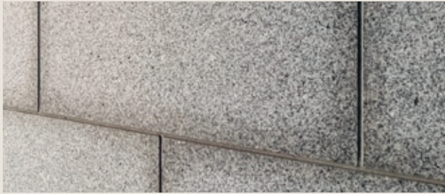
Figur 4: Ikke egnet fugemasse på granittfasade
