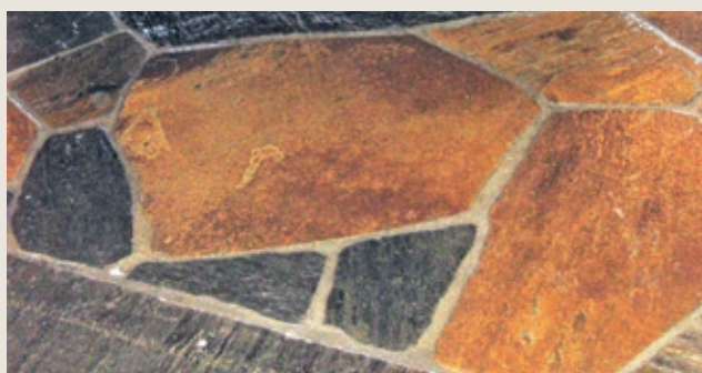
Figur 3: Avhengig av steinform og leggemønster kan fugebredden variere mye
