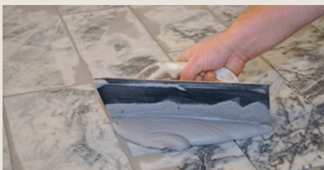
Figur 2: Egnert fugemasse og korrekt utførelse er en forutsetning for et godt resultat
