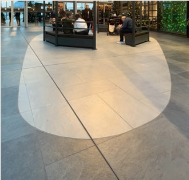
Figur 2: Fliser tilpasset ved hjelp av vannjet
