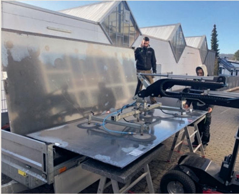
Figur 4: Transport på henger med stålstativ og minikran med vakuumløftere
