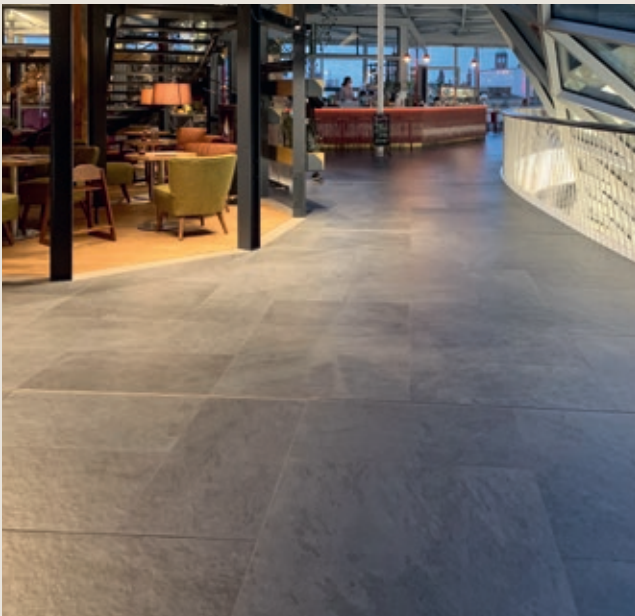
Figur 3 a og b: Bevegelsesfuger med metallkant danner her et rutemønster på ca 8 x 8 meter
