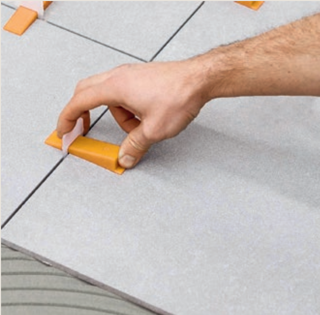
Figur 7: Kilesystem for å hindre kantsprang ved fuger
