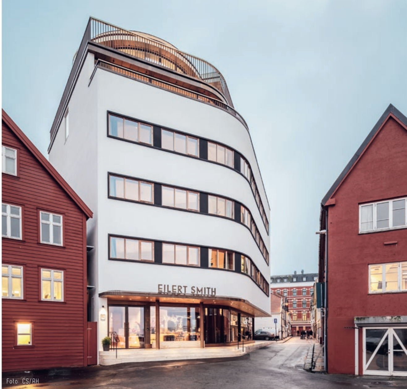
Sett fra nord. Betongfasaden ble etterisolert utvendig med en isolerende kalkmørtel
