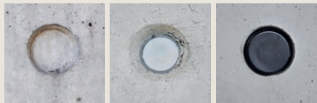
Senket gjenmørtling Senket plastplugg Sort plugg Tetting av staghull
