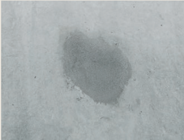
Godt synlig reparasjon
