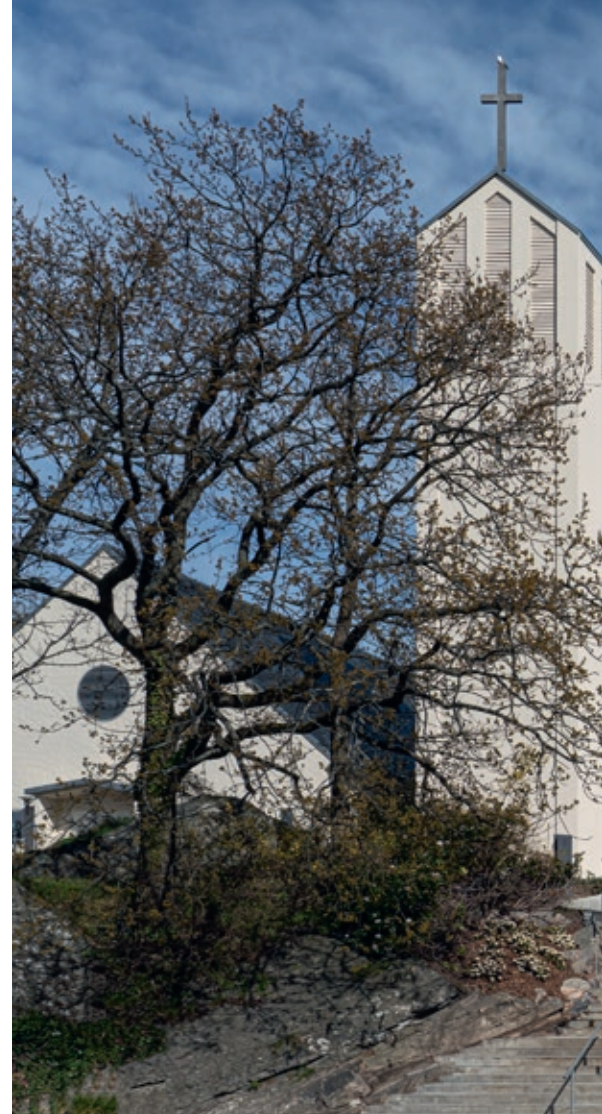
Sett fra syd – fasader i plasstøpt lys, rå betong med plateforskaling
