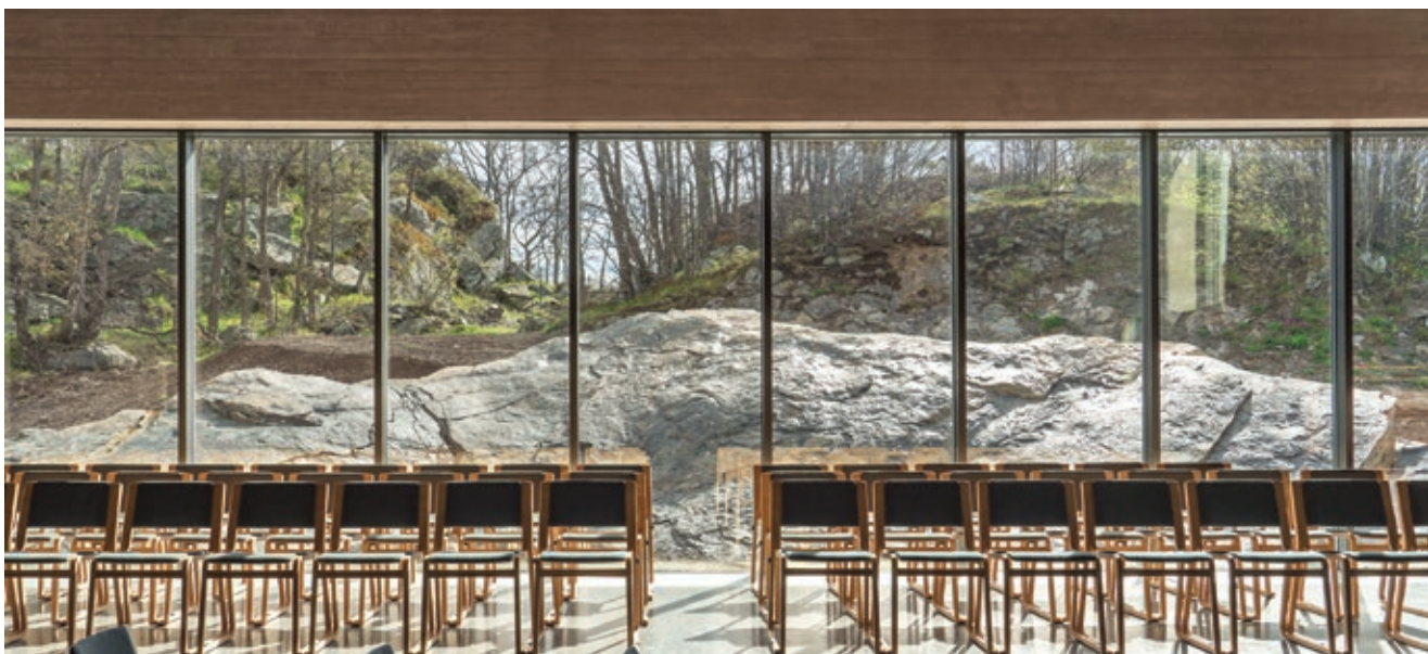
Et sammenhengende glassfelt på 25 meter under en like lang betongdrager sørger for kirkerommets karakter og lysblanding
