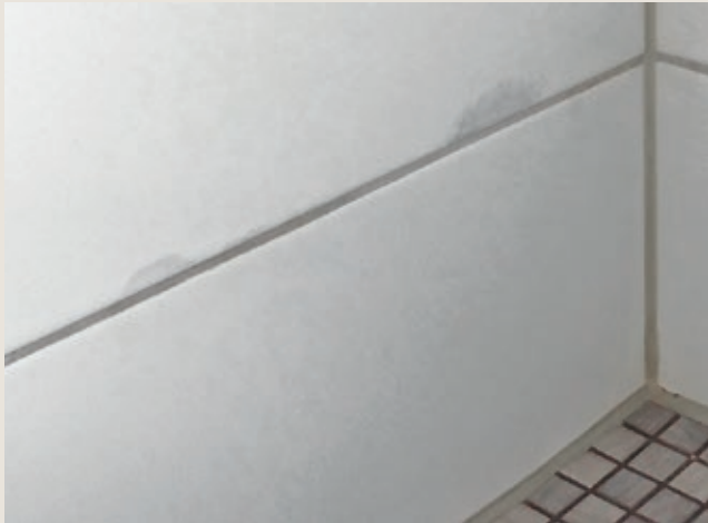
Figur 2: Fargeendringer begynner ofte ved en kant og sprer seg innover på flaten. På matte glasurer synes dette best
