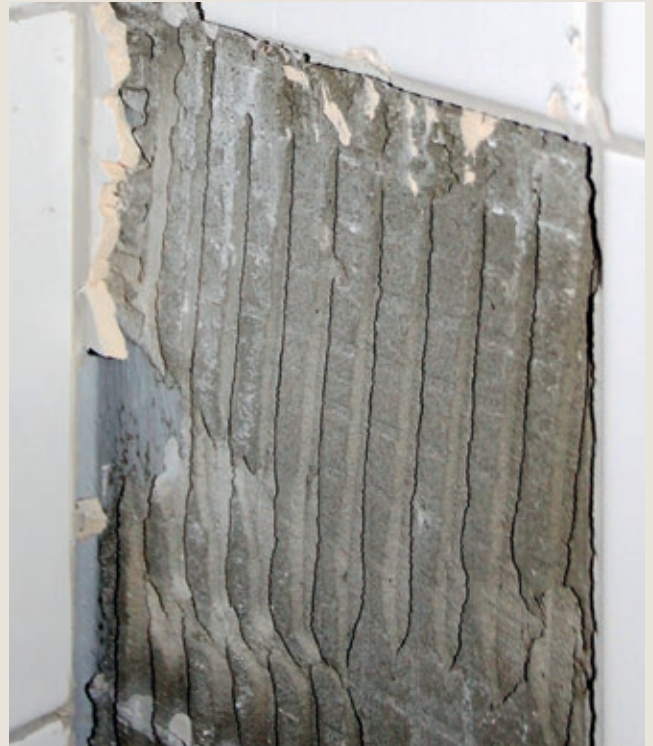
Figur 3: Vertikal påtrekk av lim er bra, men full limdekning bør tilstrebes i våtsoner. Ikke riller, som her
