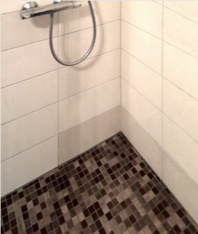
Figur 1: Slik kan fargeendringer i dusjhjørne opptre
