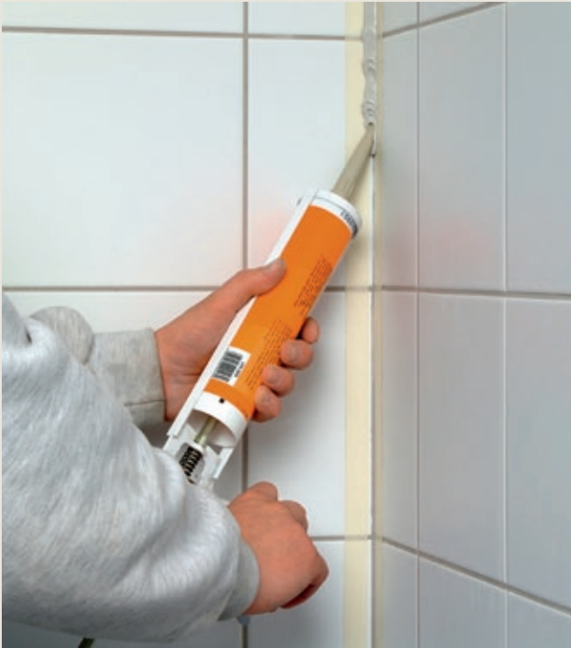
Figur 2: Bruk fargestabil elastisk fugemasse. sørg for gunstige herdeforhold. Det er tryggest å unngå hvite/svært lyse fuger
