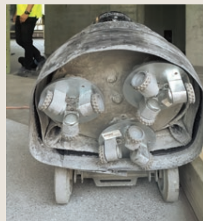
Prikkhamring av ledefelt og varselfelt rundt søyler (universell utforming)
