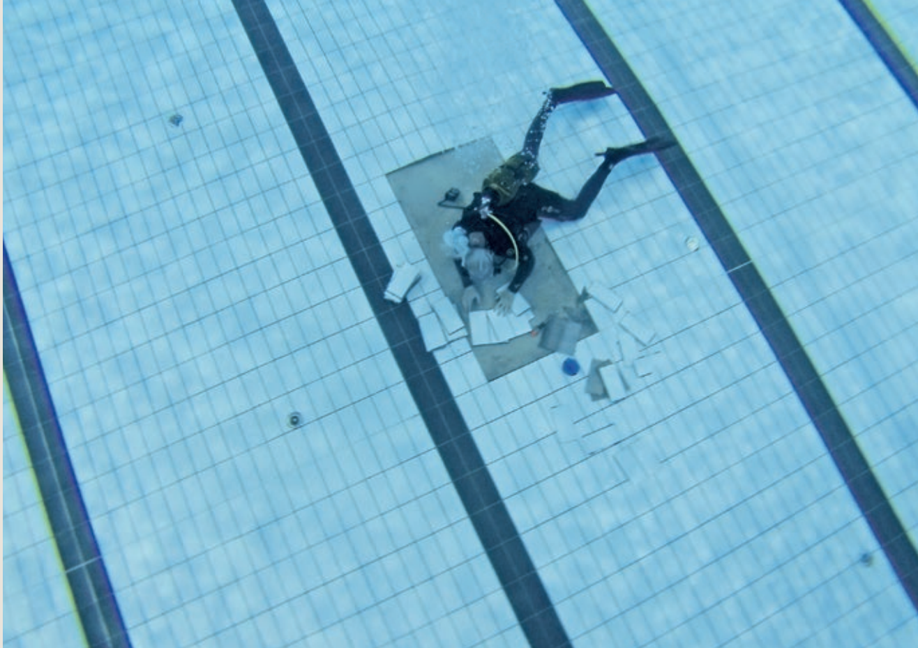
Figur 1: Reparasjoner under vann ned til 4–5 meters dybde er mulig ved hjelp av dykkerkompetanse og egnete produkter
