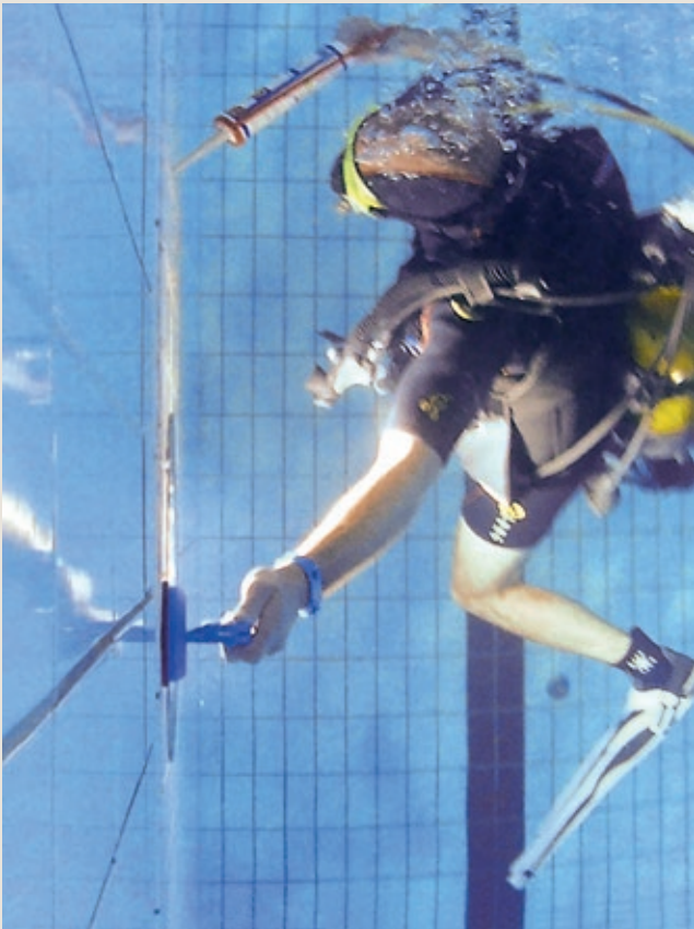
Figur 8: Fuging utføres med fugepistol. Sugekopper er et godt hjelpemiddel både på gulv og vegg for å holde seg i posisjon
