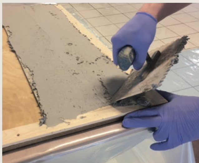
Figur 6b: Epoxy spesiallim blandes ut, trekkes på med tannsparkel og jevnes ut med Brettets glattkant
