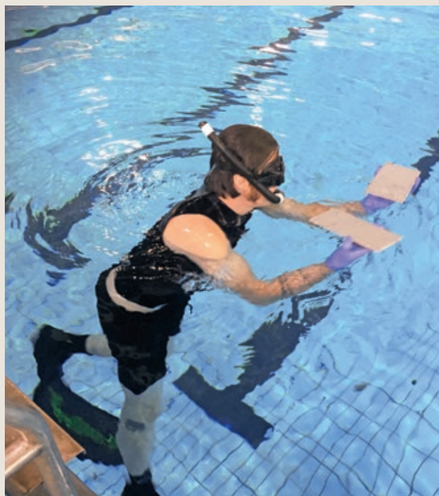
Figur 7: Fridykker bringer fliser påført lim ned til reparasjonsområdet
