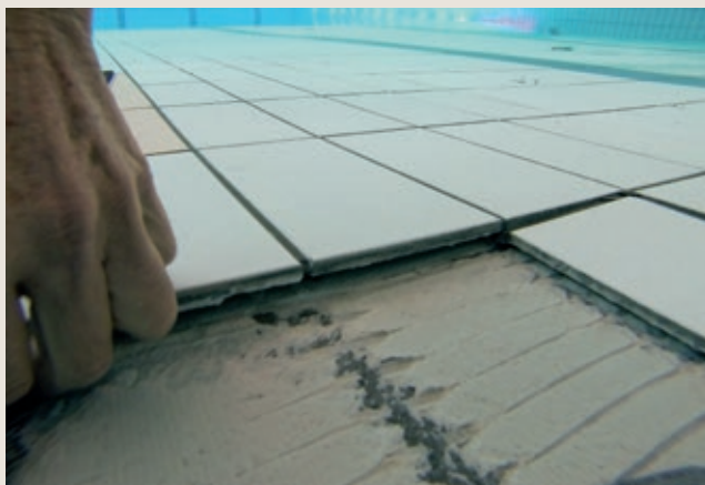
Figur 4: Sitter mye limrester fast på underlaget er det vanskelig og tidskrevende å rengjøre flaten
