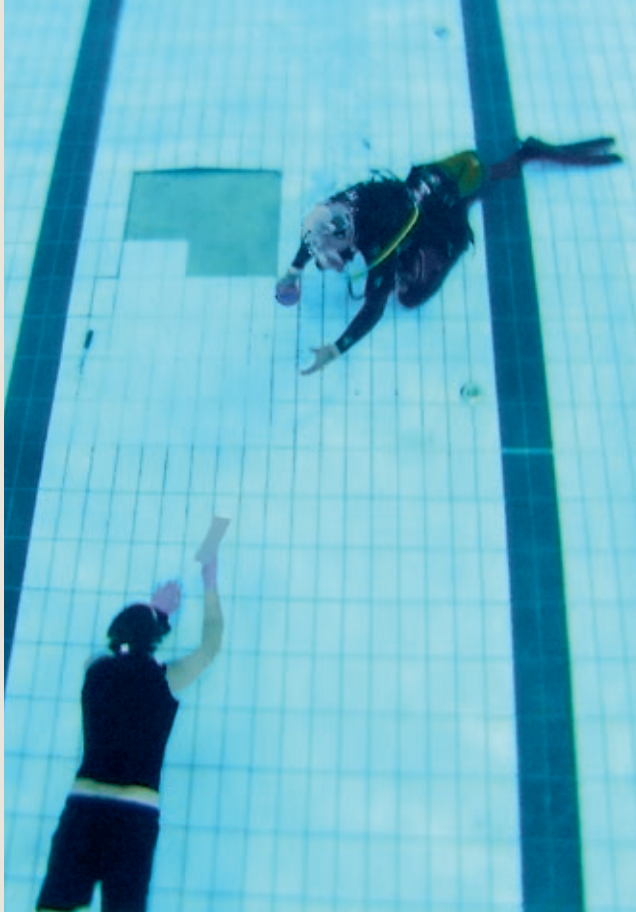
Figur 5: Erfaren flislegger med dykkerutstyr reparerer her et felt på ca. 2 m 2
