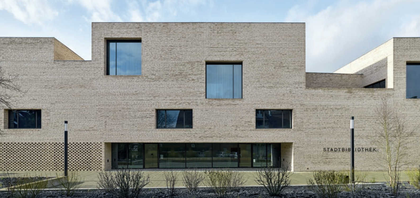
Fasade øst med hovedinngangen
