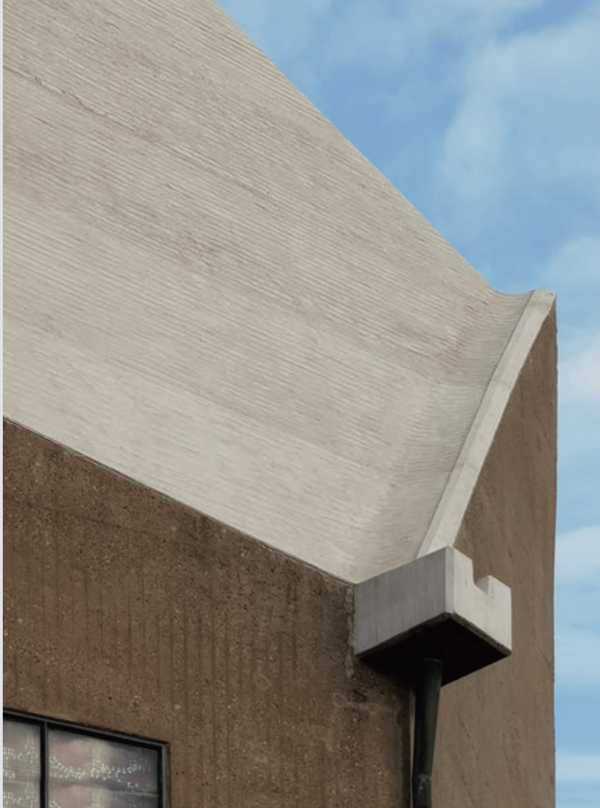
Taket tettes i syv arbeidsoperasjoner med total tykkelse 35 mm og vekt 80 kg/m 2 . Det benyttes karbonfiberbetong med et beskyttende frisert og hydrofobert toppsjikt der overflaten skal ligne forskalingsbordene fra 1968
