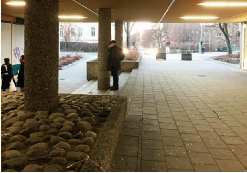
Undergangen ved biblioteket – før start
