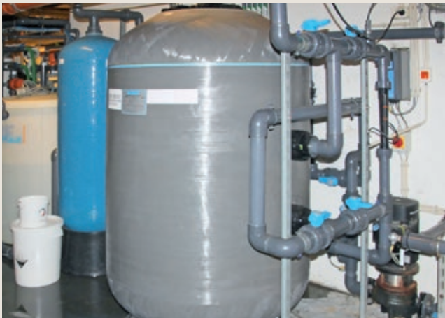
Figur 9: En marmorfiltertank som jevnlig tilfører vannet mineraler tar ikke stor plass
