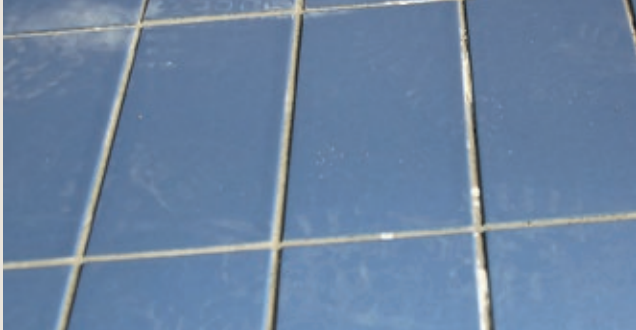
Figur 8: Er fugen så borttært at man ser ned til limet, indikerer det at vannet 'spiser opp' sementen
