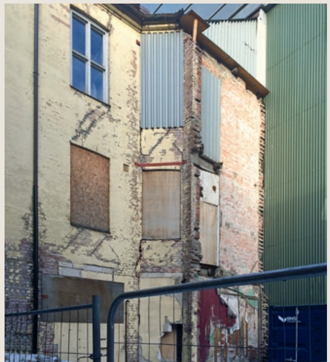
Torggata 13: Her kunne alle fasader bevares, mens en mindre skråvegg samt rivesnitt ble revet og gjenoppbygget. I gavlen måtte en del av teglveggen på loftet rives, den var ute av lodd, og i tillegg var teglsteinen frostskaadet og delvis pulverisert. Det samme gjaldt én av skorsteinene, som også ble revet.
