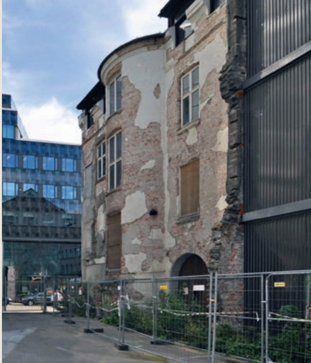
Youngs gate 7: Her ble fasadene beholdt med kun lokale utbedringer. I rivesnittene var det mye løs stein, så disse ble revet og gjenoppbygget.
