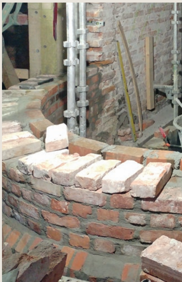
I Youngsgate 9 måtte det buede trapperommet plukkes ned stein for stein og gjenoppbygges som kopi, med samme teglstein
