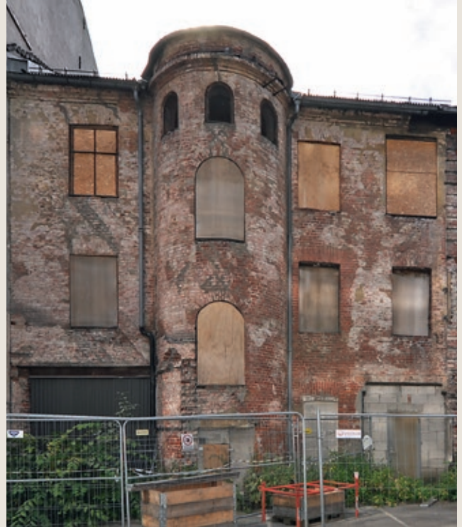
Youngs gate 9: Her var det ekstra store setningsskader. Trapperommet mot bakgården måtte rives og gjenoppbygges i sin helhet. Teglsteinene var i god stand og ble rengjort og gjenbrukt
