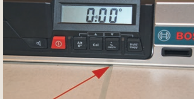
Figur 6: Er gulvet tilnærmet plant, vil et kantsprang på 1 mm lett samle noe vann. Store fliser lagt i kryssforband kan lett skape slike kanter
