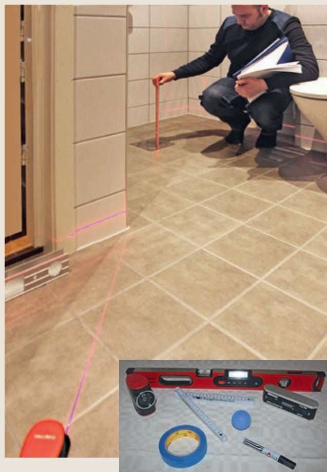
Figur 4: Kontroll av fallforhold med laser, vater, kule og tommestokk
