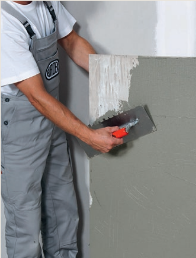
Figur 3: Lim på baksiden av flisen bidrar til god kontaktflate mellom flis og underlag
