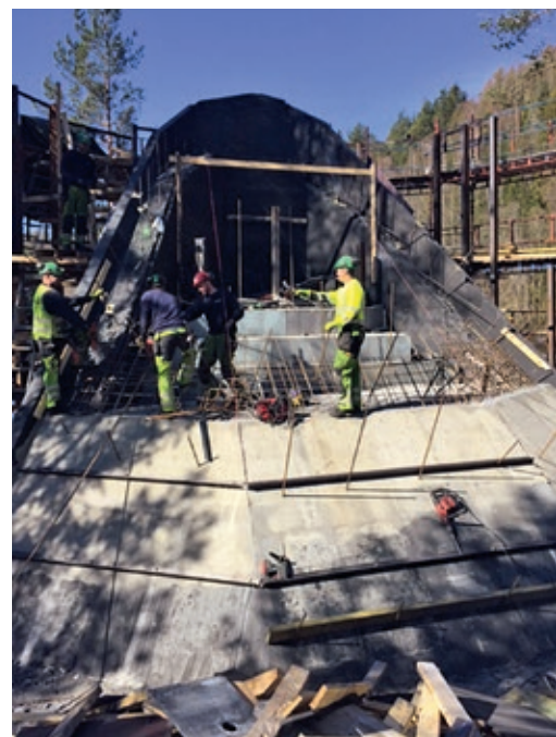
Fjellet' ble delt opp i fire støpeetapper, fordelt på totalt 200 m 3 betong og 10 tonn armering
