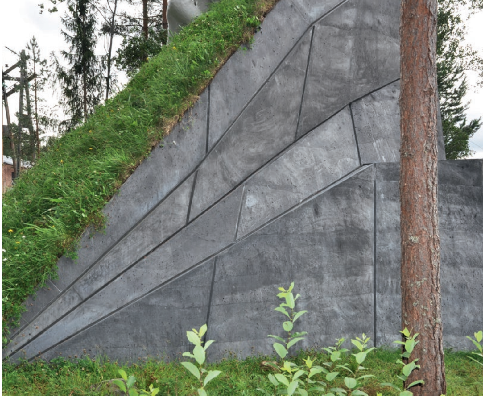
Fjellet' ble delt opp i fire støpeetapper, fordelt på totalt 200 m 3 betong og 10 tonn armering
