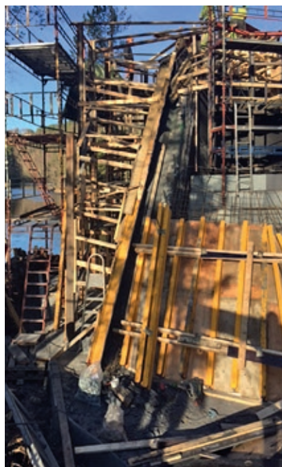
Fjellet' ble delt opp i fire støpeetapper, fordelt på totalt 200 m 3 betong og 10 tonn armering
