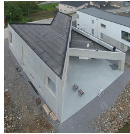
Under bygging. Huset er utformet som en X
