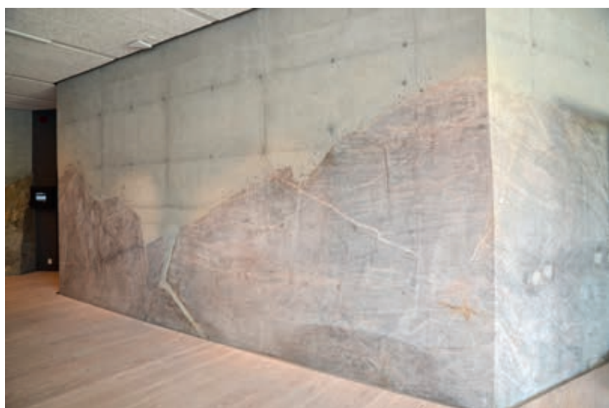
Eksponert fjell i samvirke med plasstøpt betong
