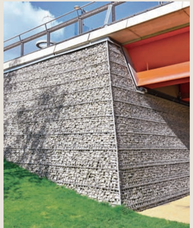
Gabionvegg i knust betong
