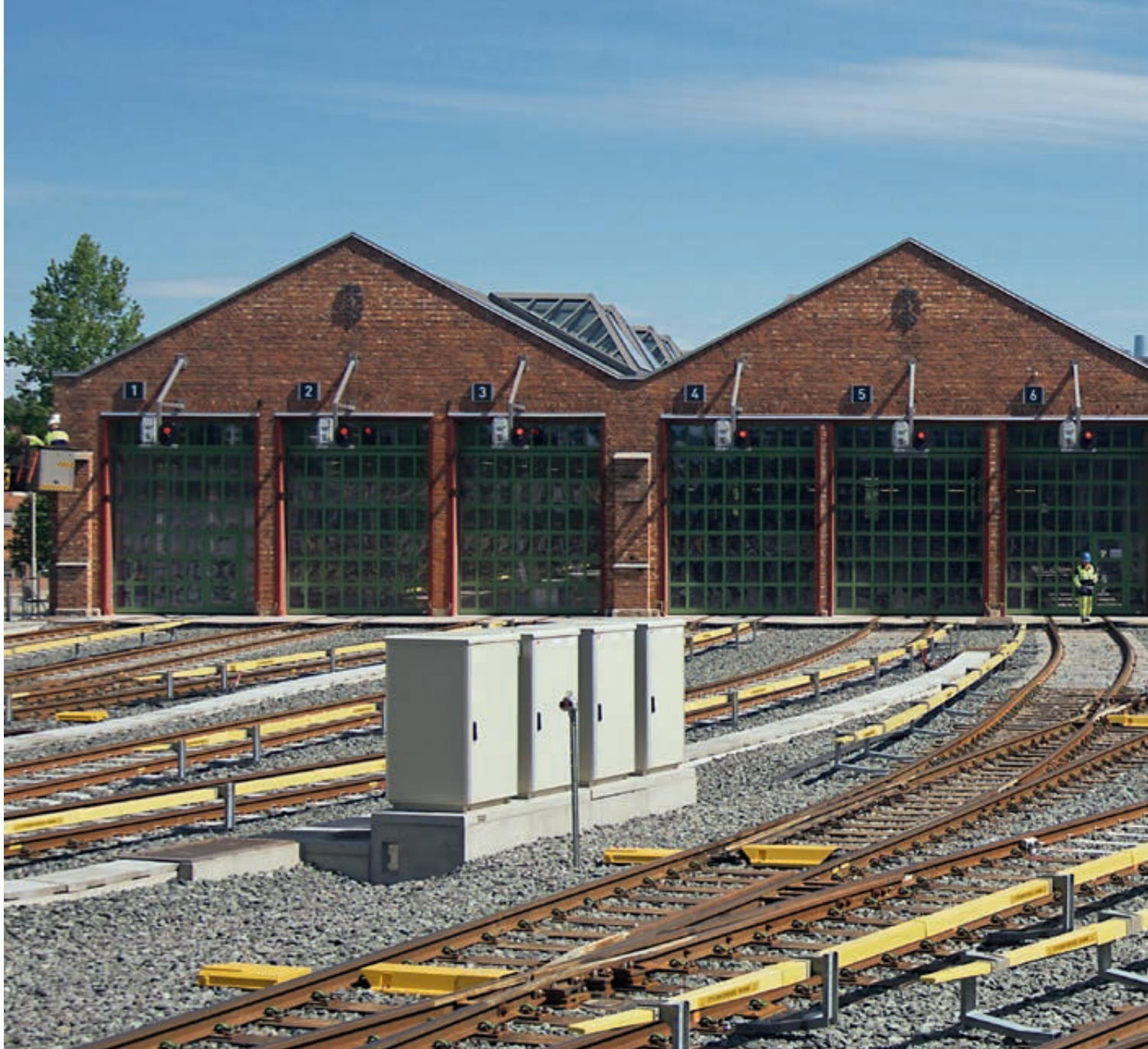
Mot sør-vest. Eksisterende vognhall har 'dobbel' saltak, to saltak ved siden av hverandre med rennedal mellom. Den nye vognhallen har en takform med motsatt retning: taket ligger vekselvis på undergurt og overgurt i fagverksdragere
