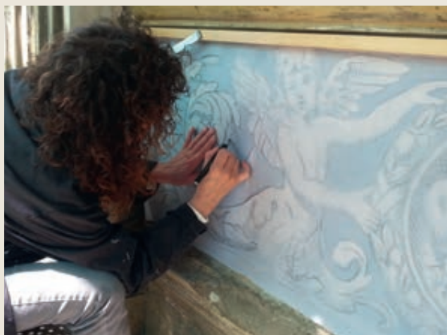
Motivene ble avtegnet i 1:1 på plastbelagt kalkerpapir
