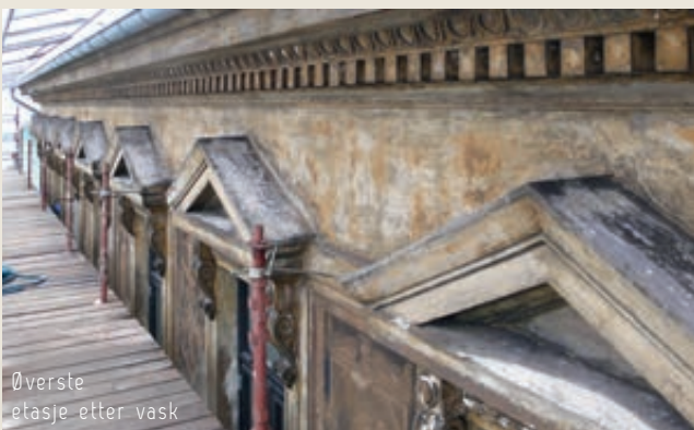
Sementbasert pussmørtel utenpå gipstrekkinger
