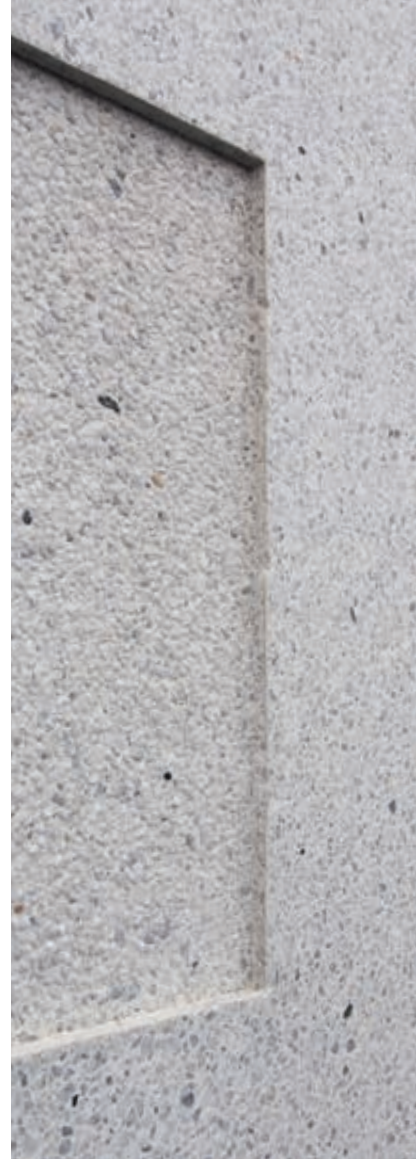
Bærende sandwich-elementer i hvit betong med marmortilslag. Forskalingsplatene som danner relieffene ble påført retarder, noe som gir en ru overflate (frilagt betong). Hovedflaten er børstet.
