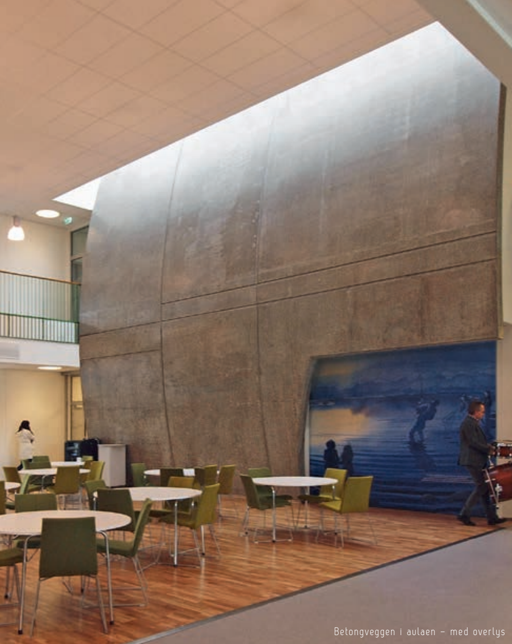
Bærende sandwich-elementer i hvit betong med marmortilslag. Forskalingsplatene som danner relieffene ble påført retarder, noe som gir en ru overflate (frilagt betong). Hovedflaten er børstet.
