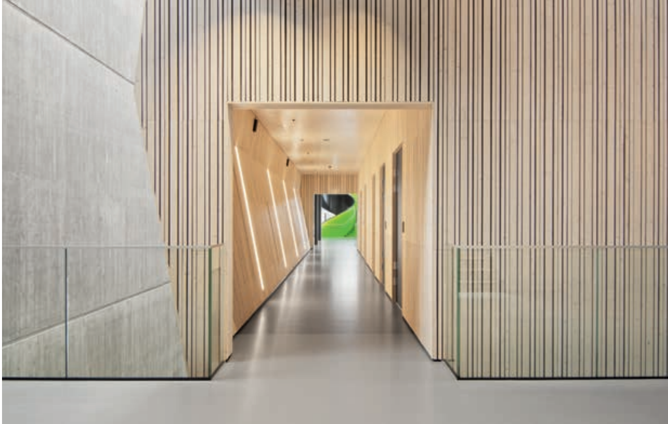
Området for musikk- og kulturskole. Hvitlasert granpanel i kombinasjon med bordforskallet betong. Rekkverk i helglass
