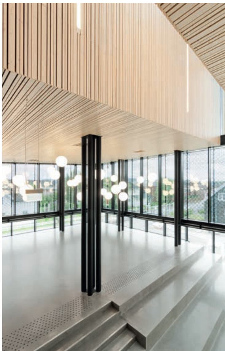
Amfi i biblioteket, golv i stipt betong
