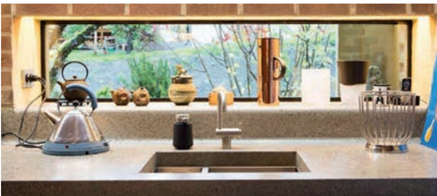
God planlegging er viktig. Her ble huset murt rundt den monterte benkeplaten. (Knut Hjeltnes Sivilarkitekter)
