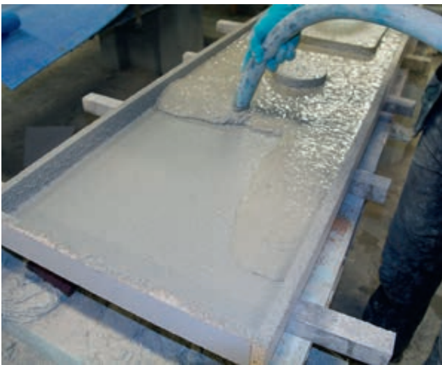
Ifylling av backcoat: fiberbetong
