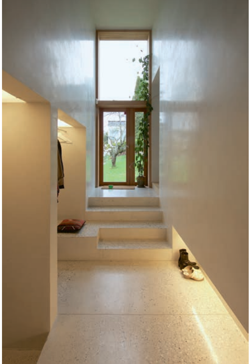
Inngangspartiet er høyt, smalt og nesten sakralt i sin enkelhet. Gulvene er av slipt betong, med hvit sement og tilslag av hvit kvarts. Porebetongveggene er behandlet med lysegrå stucco lustro
