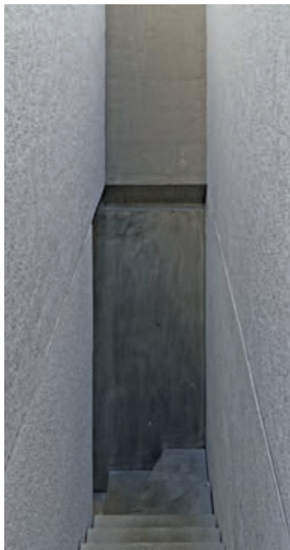
Elementtrapp med overlys. Prikkhogget overflate med marmortilslag
