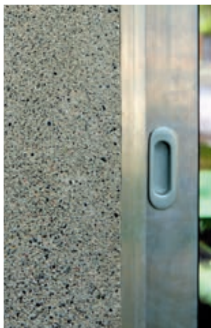
Miniretardert betong i fasadene. Vinduer og dører er i råaluminium
