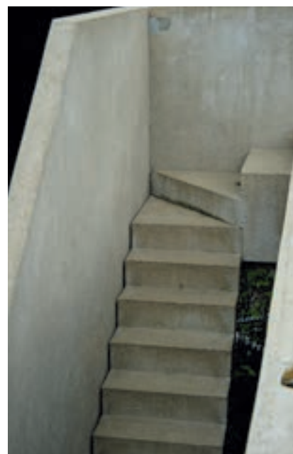
Utvendig trapp til takterasse
