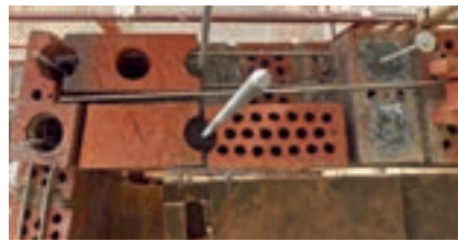
Fra oppmuring og utstøping av armert murbjelke i etasjeskillet ved hushjørnet Foto: FEM
