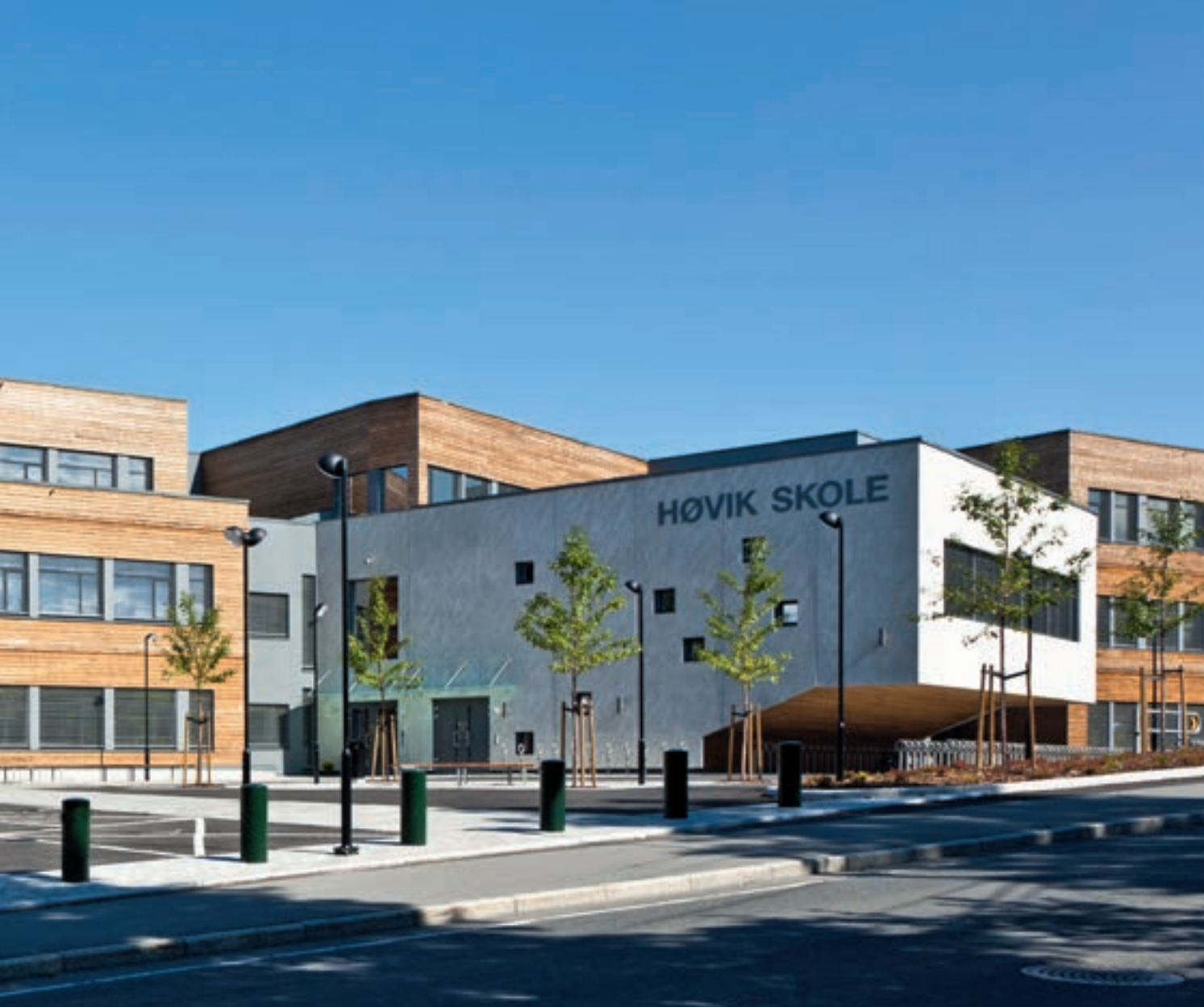
Skolen sett fra sydvest. Nybyggets fasader tar opp rytmen fra den bevaringsverdige teglbygningen
