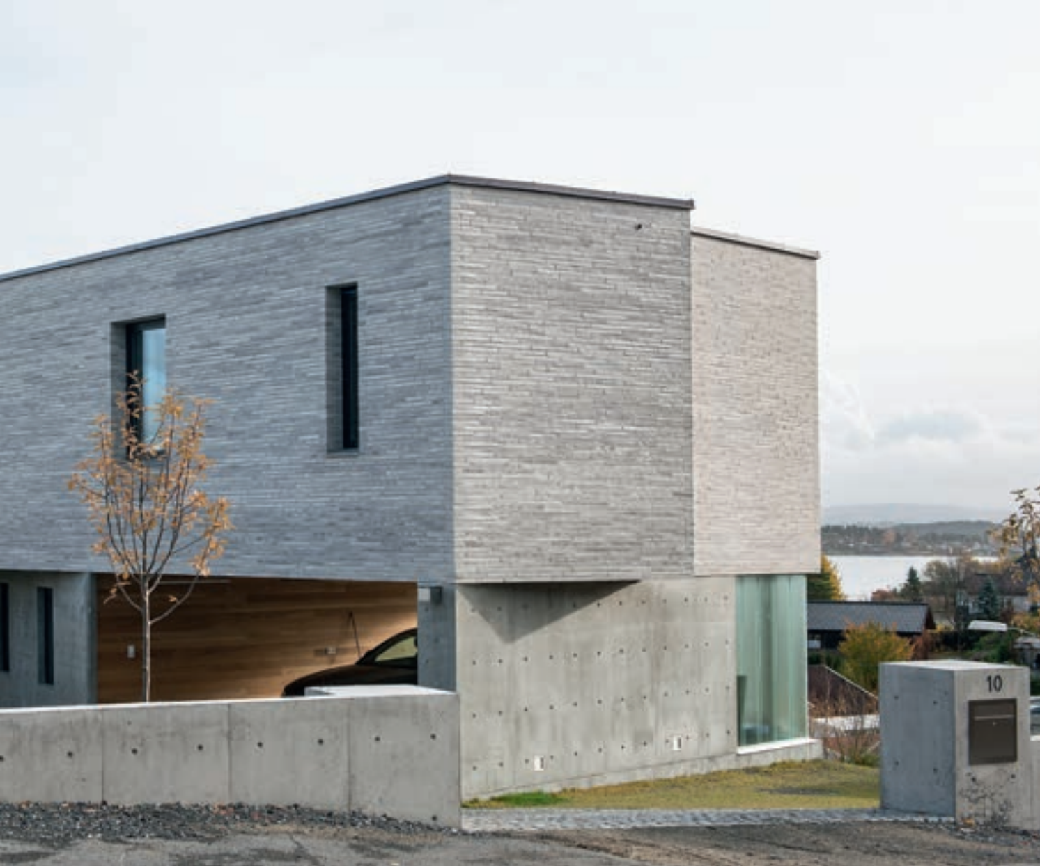
Fasade mot nord med innkjøring fra P.T.Mallingsvei
