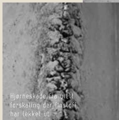
Utette former gir skyggevirking i formskjøtene
