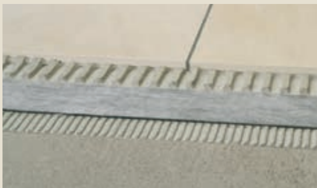
Figur 3: Eksempel på 3–5 mm matte som limes til underlaget
