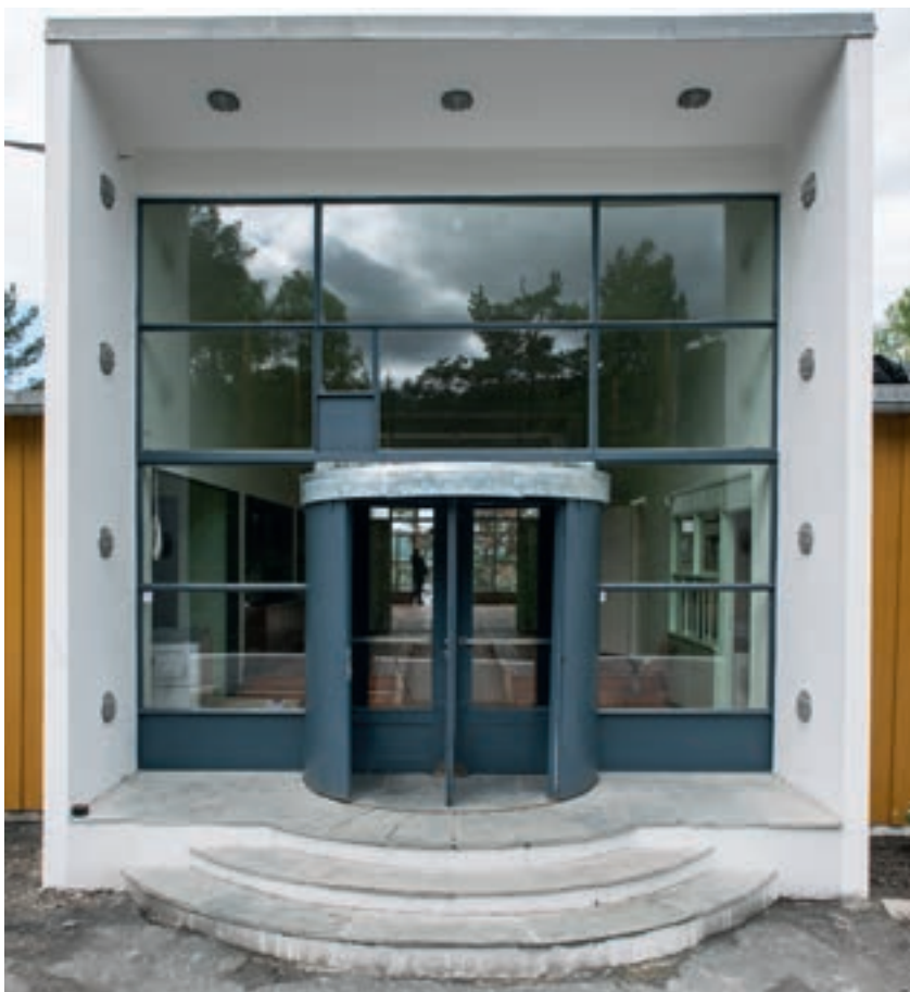
Inngangspartiet viser de slanke betongkonstruksjonene som er typiske for bygget
