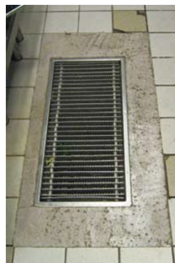
Figur 8: En typisk situasjon der både lim og støpemasse har forvitret og det må utføres midlertidige reparasjoner. Dette kan unngås ved å bruke løsninger som f.eks. prinsipp 2.
